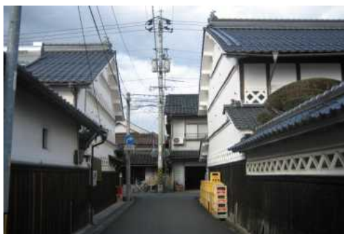
宿場町の面影を残す建物（久世地域）
