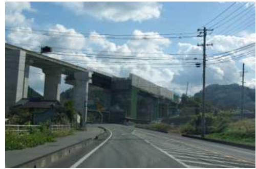
○国道181号と米子自動車道（久世地域）
